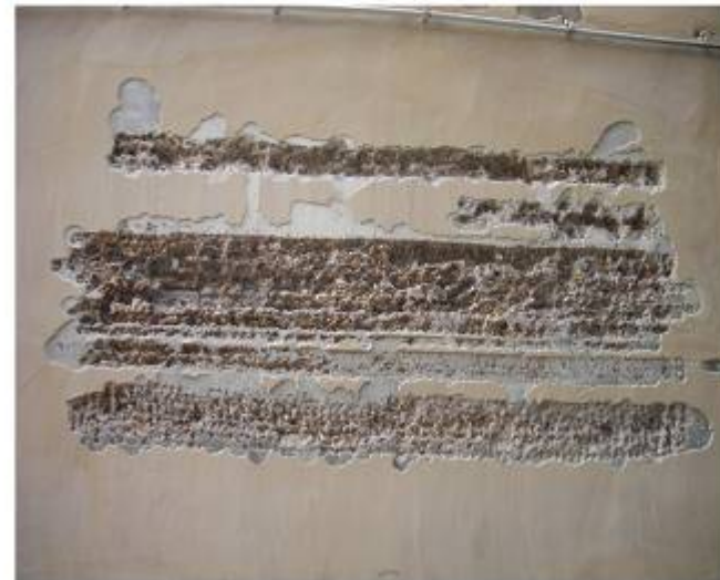
LAAGBOUW: RESULTAAT DIVERSE MANUELE BETONVERWIJDERINGSPROEVEN
