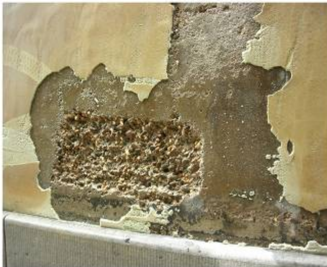
LAAGBOUW: MANUELE BETONVERWIJDERINGSPROEF IN UITVOERING
