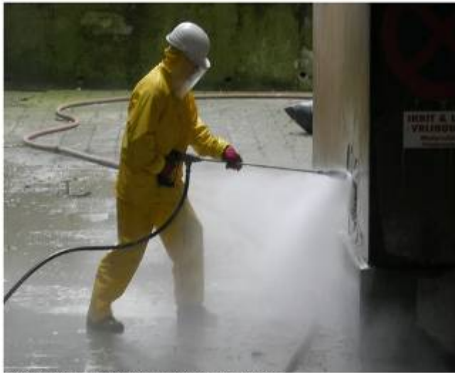
LAAGBOUW: MANUELE BETONVERWIJDERINGSPROEF IN UITVOERING
