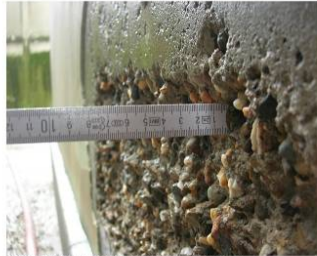
LAAGBOUW: RESULTAAT MANUELE BETONVERWIJDERINGSPROEF - DIEPTÉ 1 ± 2,5 cm
