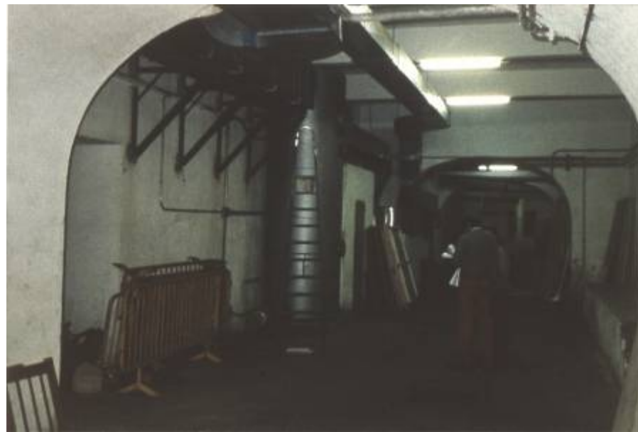
Acceso a zona de Proceso
