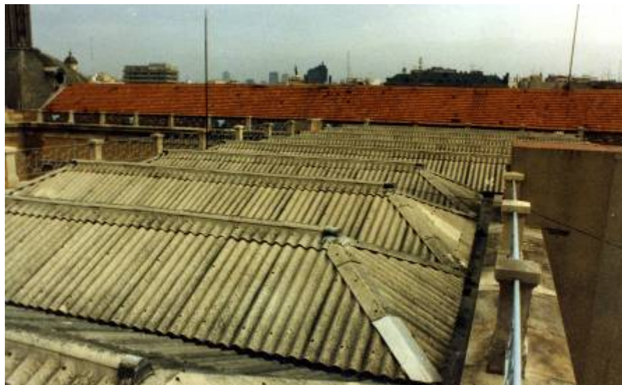
Cubiertas del Depósito General
